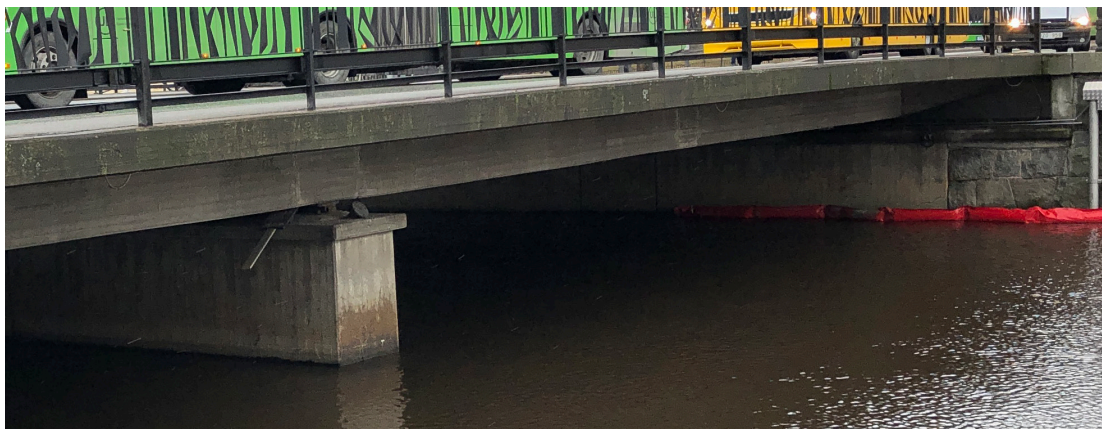
Bilden visar brons nedböjning vid mellanstödet.
