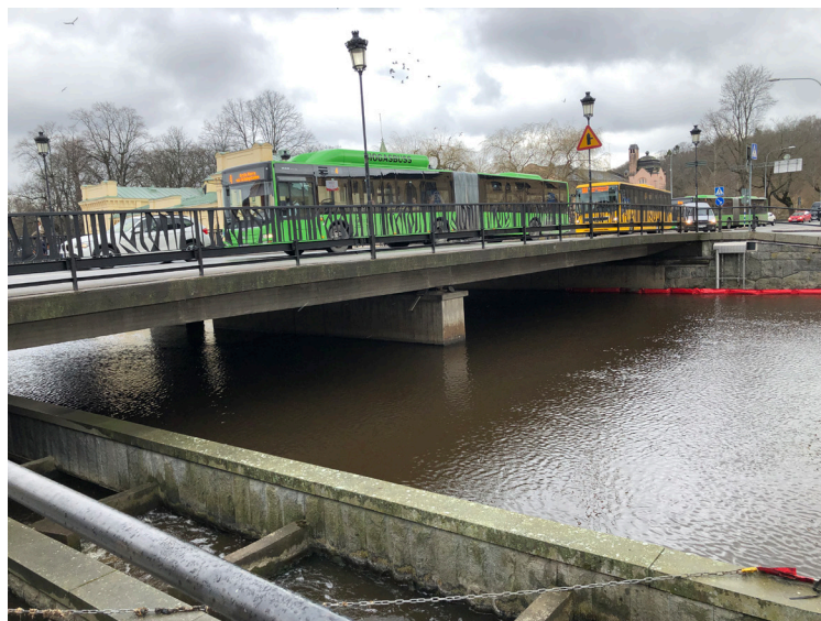
Vattenrummet under bron med asptrappa.
